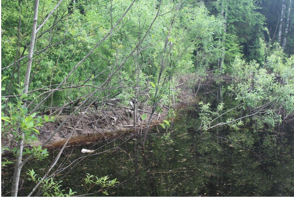
Рис.8. Плотина 1 на ручье, впадающем в Нелку
